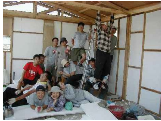
강원도 태백 칠암에서의 집짓기 봉사
